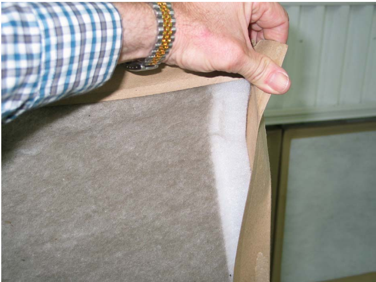
Figure 1 : Filtre cartonné placé sur le retour de l'air dans une chambre de conditionnement du miel. Il faut remarquer la poussière retenue par le filtre et qui autrement circulerait à travers les rayons.
