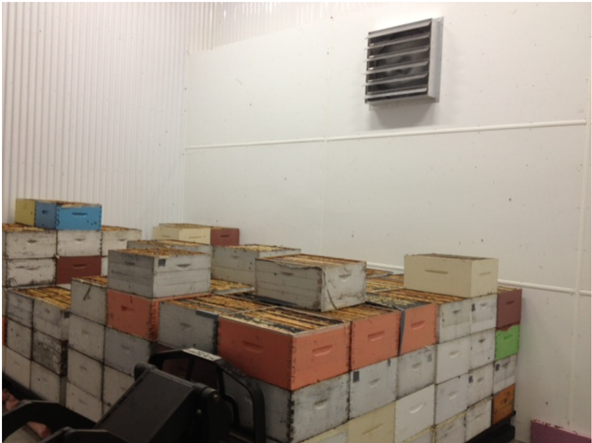
Figure 3 : Les palettes sont appuyées contre le mur du plénum. Le ventilateur situé dans la partie supérieure du plénum aspire l'air par une ouverture continue au bas du plénum qui donne sur le côté ouvert des palettes. Sur cette photo, 4 palettes sont appuyées directement au plénum et deux autres palettes sont adossées à la première. Dans ce cas-ci, 12 palettes sont ventilées. Un blocage en arrière et au bas de la dernière palette est requis. L'ouverture au bas étant continue, l'air entre par le dessus de toutes les piles.
